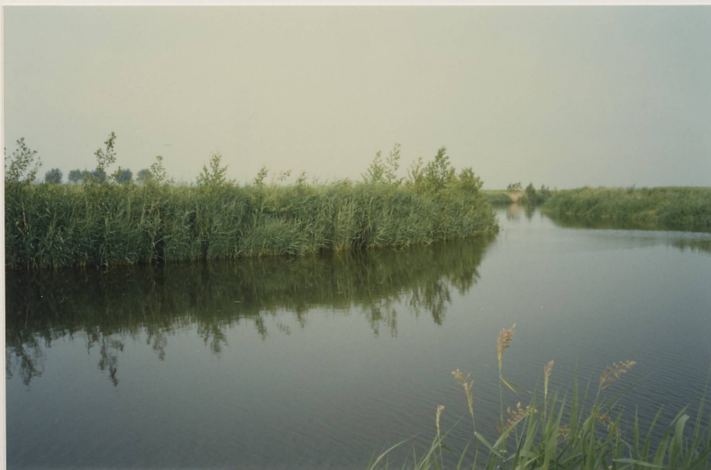
Bij de verbredingswerken aan het Grootgeleed werden de oevers plaatselijk aangelegd met een plasberm met riet- en elsbeplantingen. De rietstekken werden geplant in mei 1989 Foto juni 1992.
