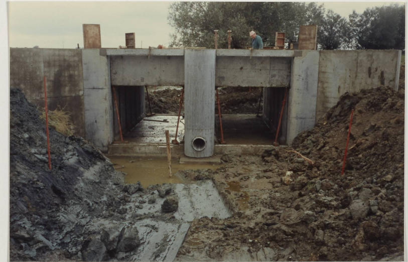
Bij de bouw van de afsluitschuiwen op de Beverdijkvaart te Nieuwkapelle werd in de middenpijler een aalgoot aangebracht voor de palingmigratie.
