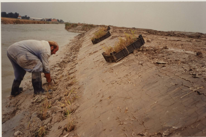
Op de schuin afgegraven oever worden vooraf gekweekte rietplanten geplant.
